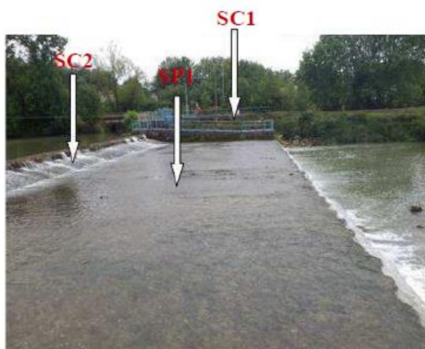
Image 7 : Implantation des sondages SC2, SP1 et SC1 coté aval du barrage au niveau du radier.
